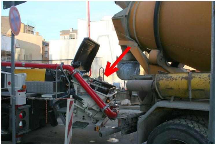
Vom Betonmischer wird der Beton in die Öffnung (roter Pfeil) des Autos mit der Pumpvorrichtung geleitet. Von da aus wird der Beton durch den langen Riesen-Pump-Arm (siehe Foto 2 und 3) auf die Bodenplatte befördert und dort von den Arbeitern verteilt.
