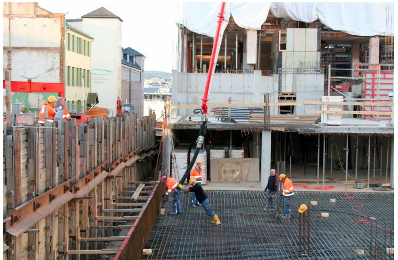
Am 21. März 2014 goss die Firma S&P aus Lengsfeld die große Betonplatte für den fünfgeschossigen Neubau des Landratsamtes an der Ecke Forststraße/ Rädelsstraße innerhalb eines Tages. 700 Kubikmeter Beton wurden per Fahrmischer antransportiert, mit Betonpumpen in die Baustelle gefördert und dort durch Betonrüttler eingebaut.
