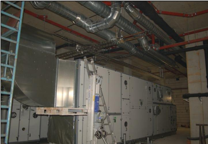
Der künftige Kreistagssaal ist auch auf „dicke“ Luft eingerichtet. Mit moderner Lüftungstechnik, die sich im Stockwerk darunter befindet, wird die verbrauchte Raumluft gegen Frischluft ausgetauscht.
