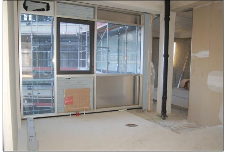
Im Inneren entstehen nach und nach die Büroeinheiten. In modularer Trockenbauweise aufgebaut, können später Wände bei Bedarf problemlos versetzt werden.
