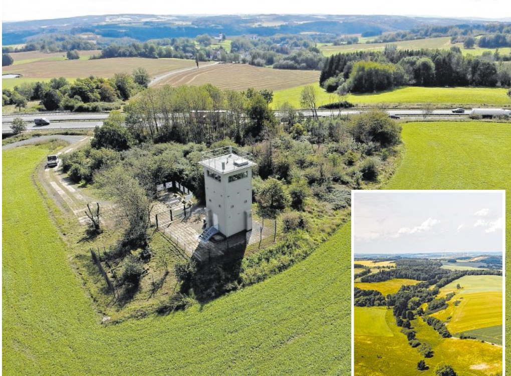
Auch der Grenzturm Heinersgrün und der weiterreichende Kolonnenweg (kleines Bild) gehören zum „Grünen Band“. Foto: Landratsamt
